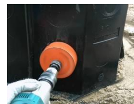
Ad.5. Vyrezanie otvoru
