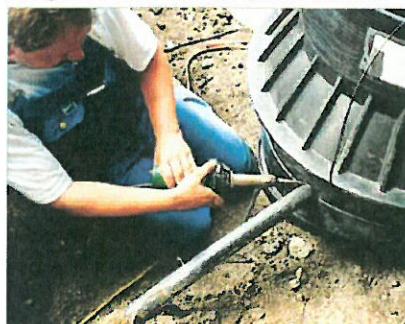
Energie AG Oberösterreich: Sváření elementů.
