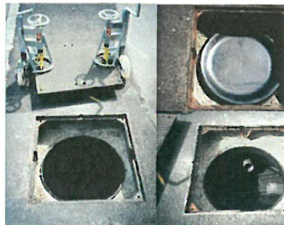
Těsný pokloповý systém s oddělenou těsnicí a nosní funkcí.
