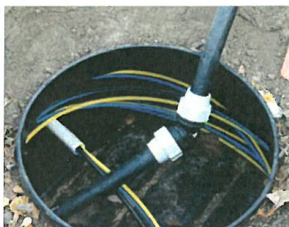
Připojení optických kabelů pomocí PLASSON kolena 45°.
