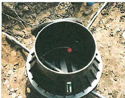
Energie AG Oberösterreich: Zafouknutí dodatečného optického kabelu.
