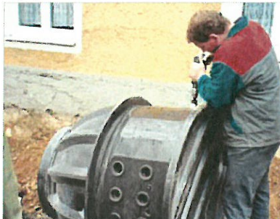
Napojení trubek a montáž těsnění na místě.
